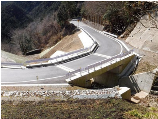
県道瀬戸設楽線 田峯 地内
