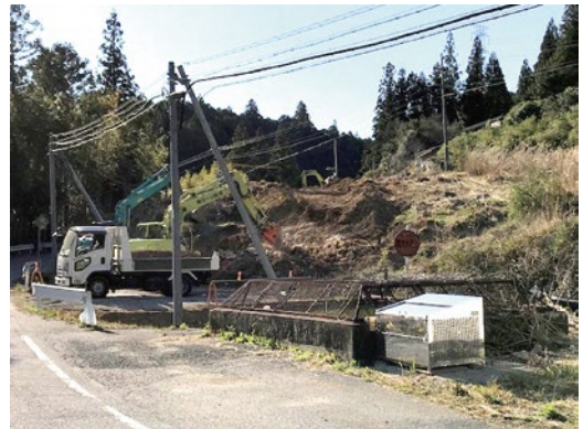
国道473号 神田 地内
